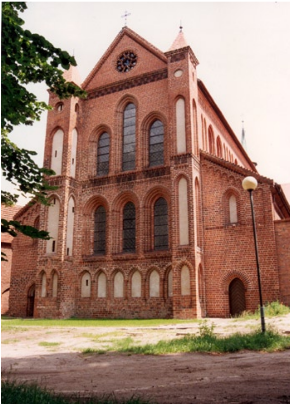
Westgiebel nach der Restaurierung.
