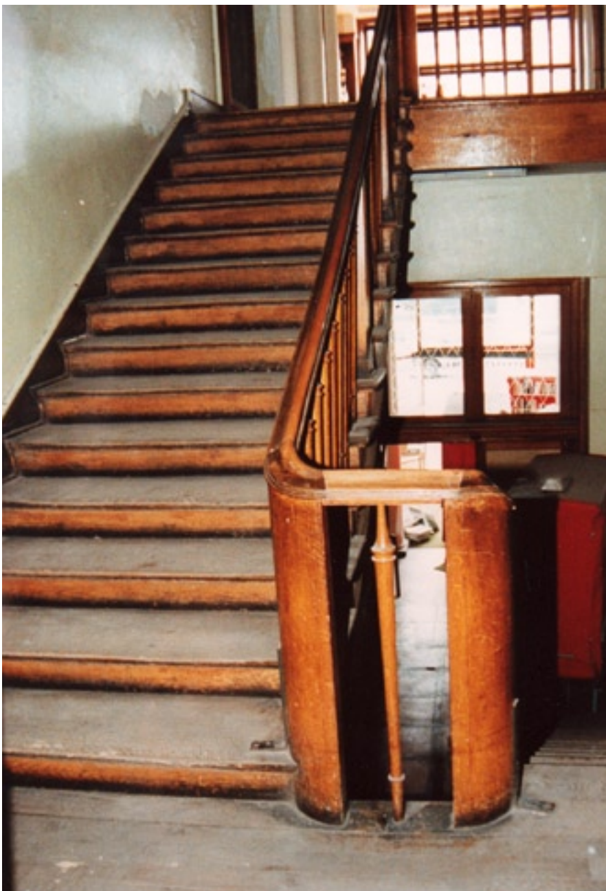
Zustand vor der Restaurierung
