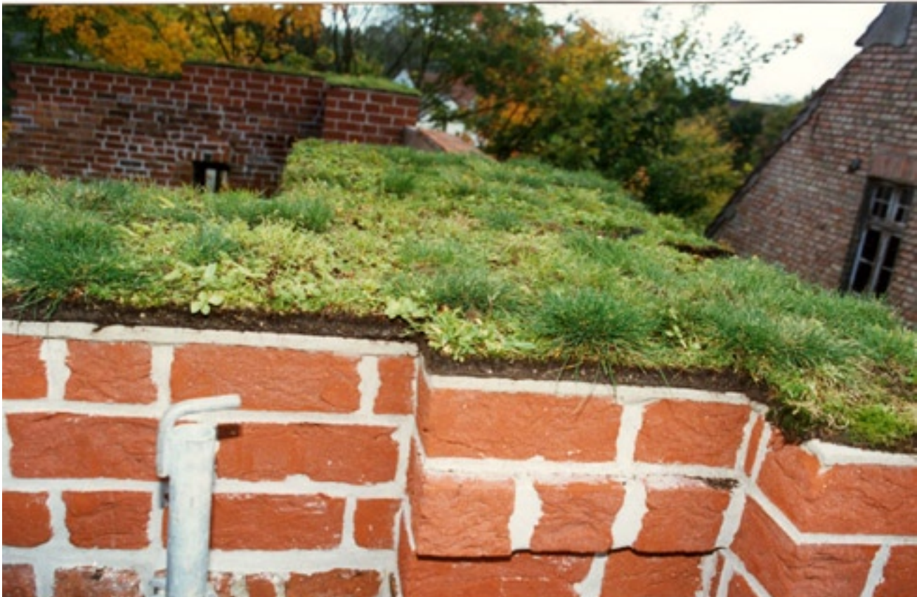
Zustand nach der Restauration des Mauerwerks mit Begrünung.
