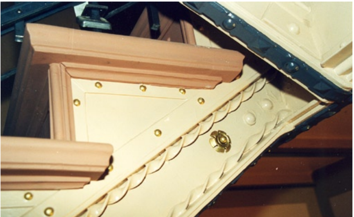
Detailansicht nach der Rekonstruktion
