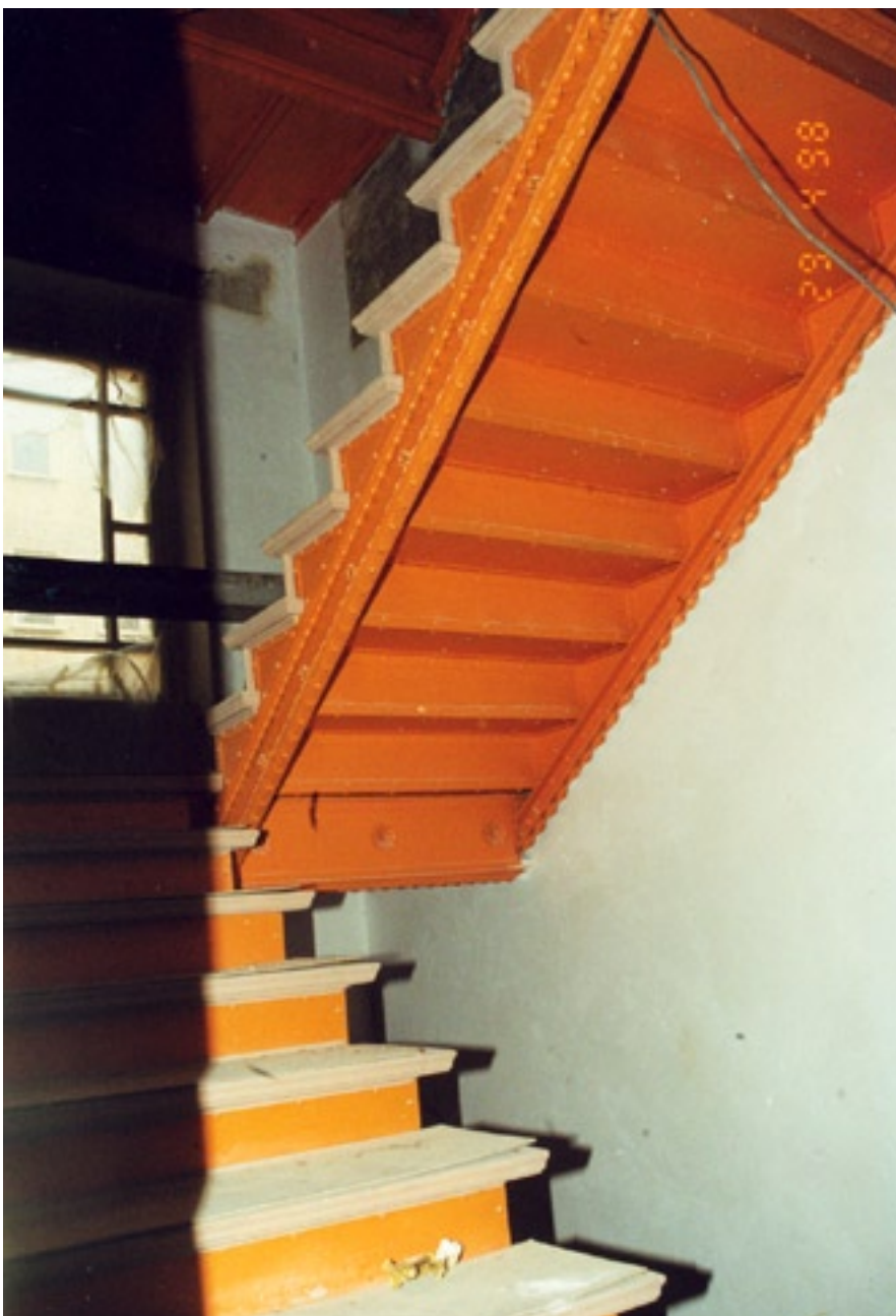
Zustand nach der Restaurierung
