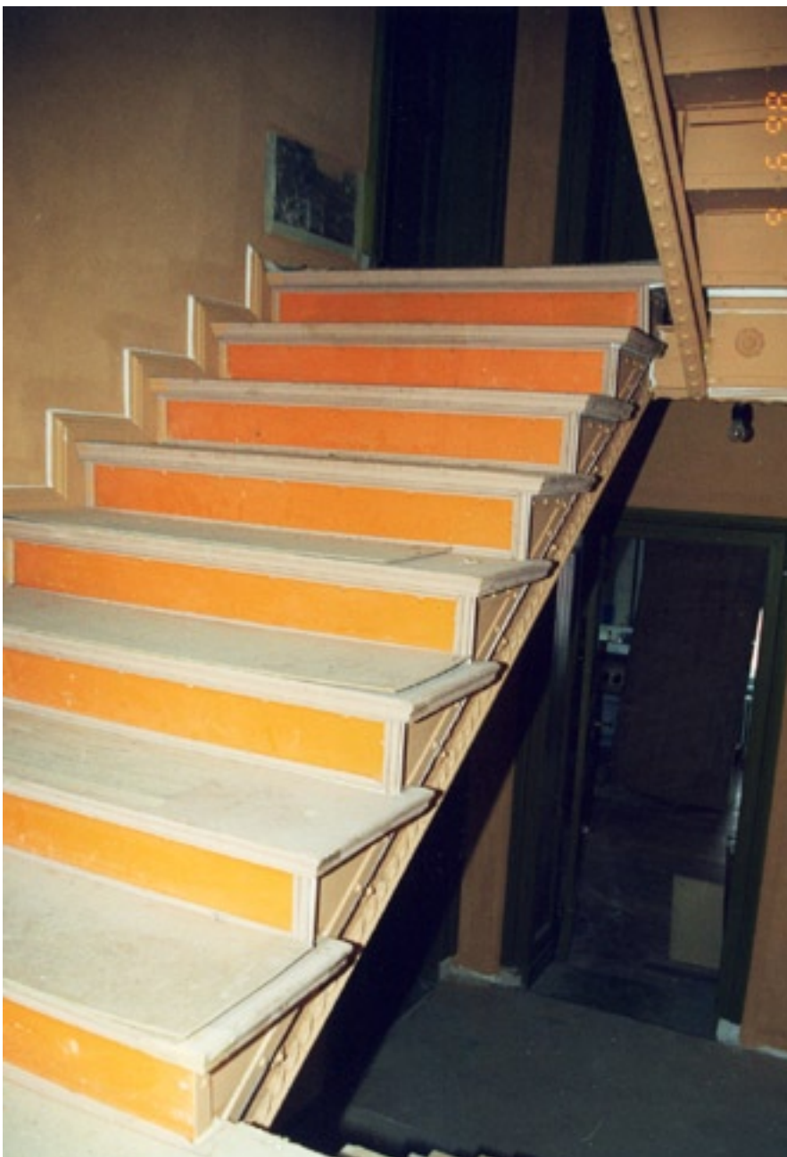
Zustand nach der Restaurierung
