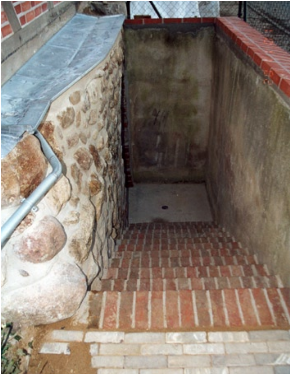
Zustand nach Fertigstellung der Arbeiten.
