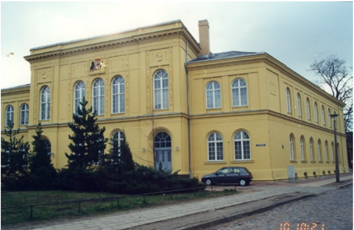
Zustand nach der Restaurierung.
