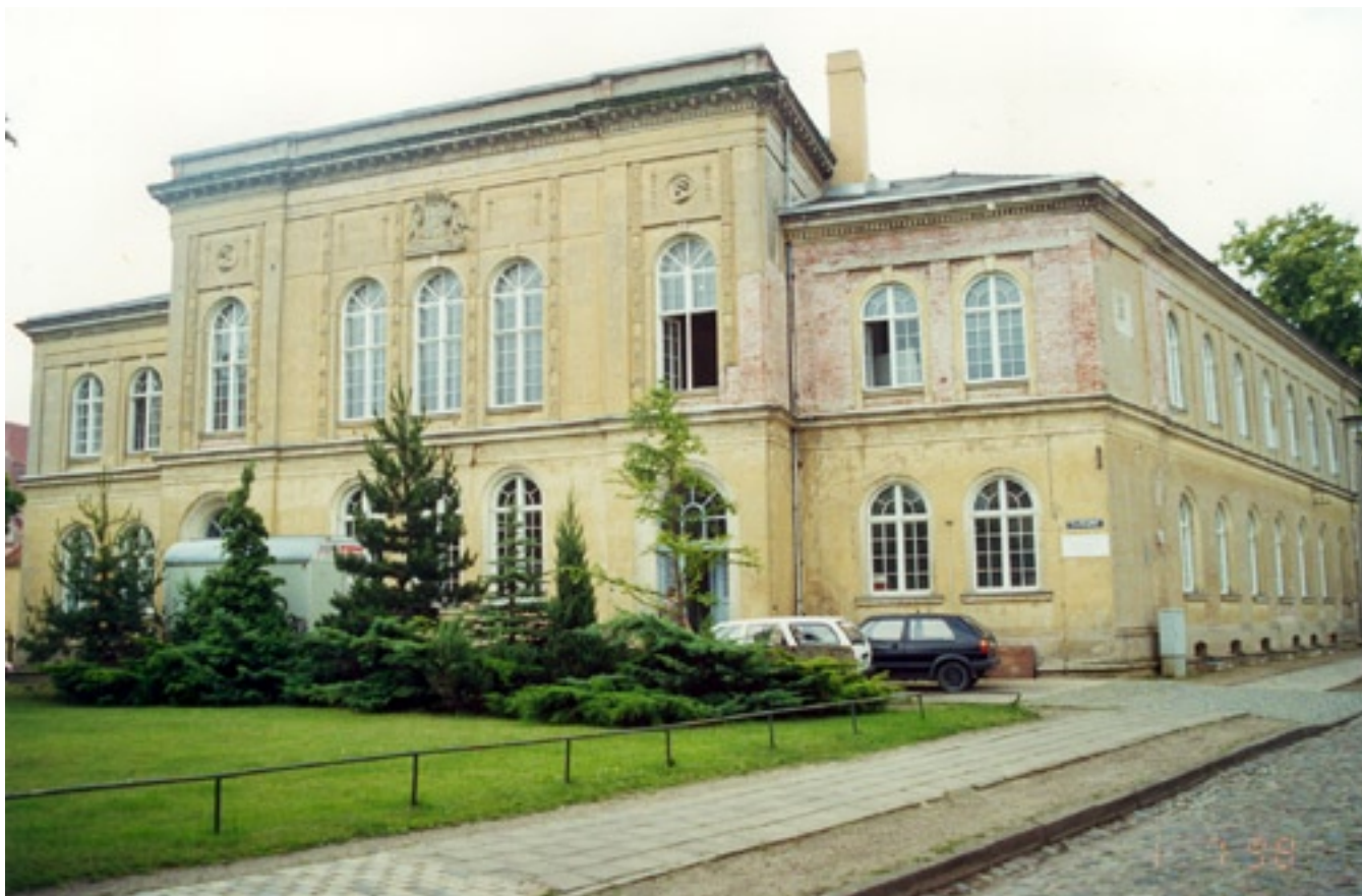
Zustand vor der Restaurierung.
