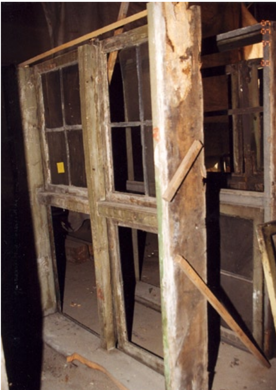
Ausgebaute Fenster vor der Restaurierung
