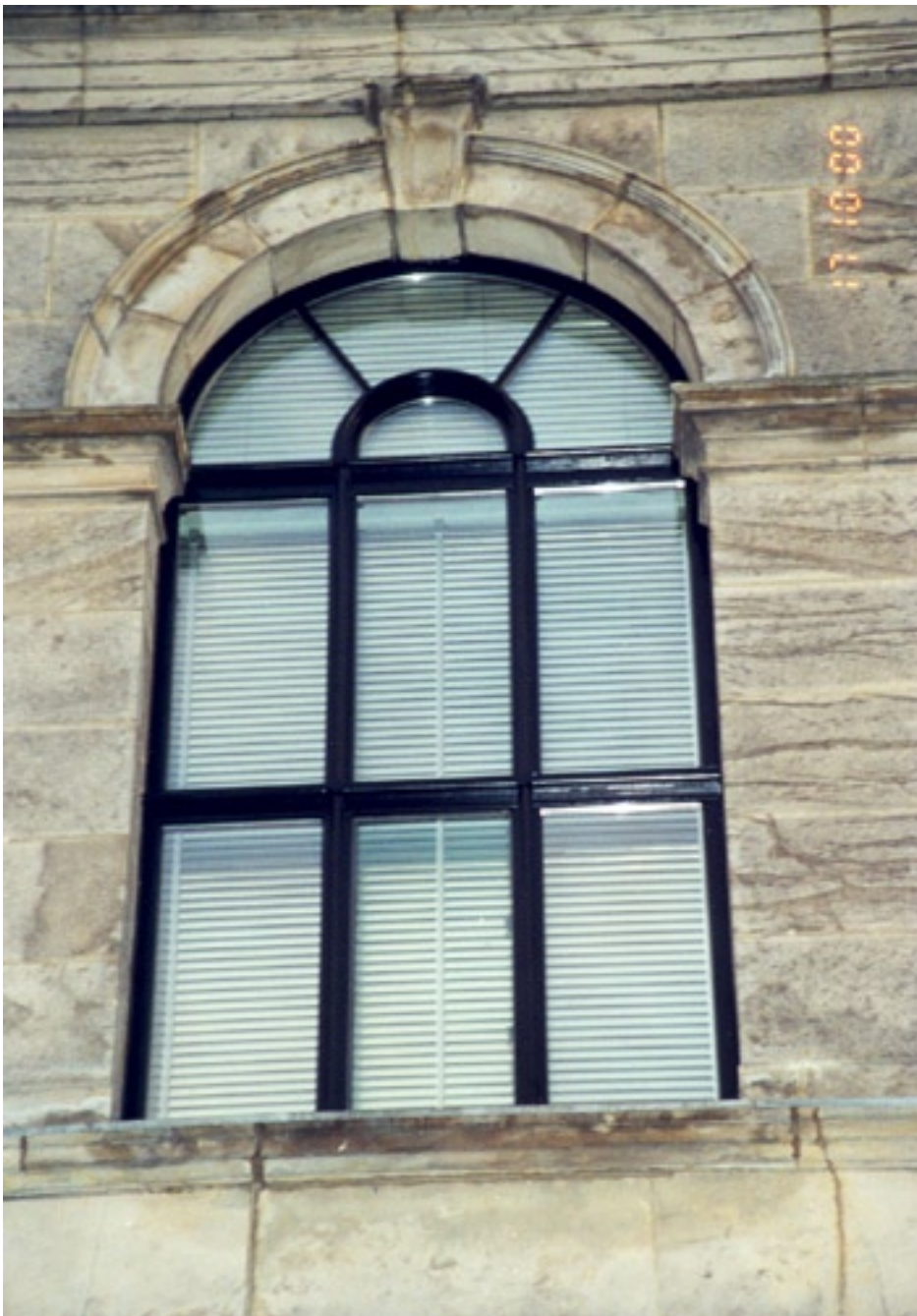
Zustand der Fenster nach der Fertigstellung
