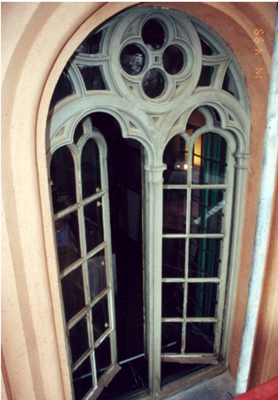
Zustand vor der Restaurierung
