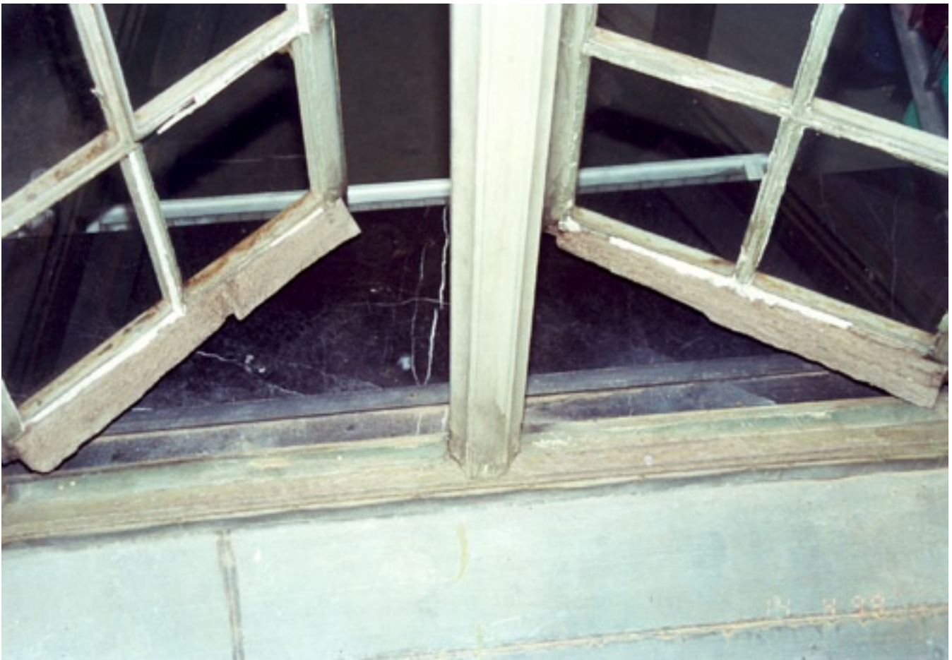
Zustand vor der Restaurierung
