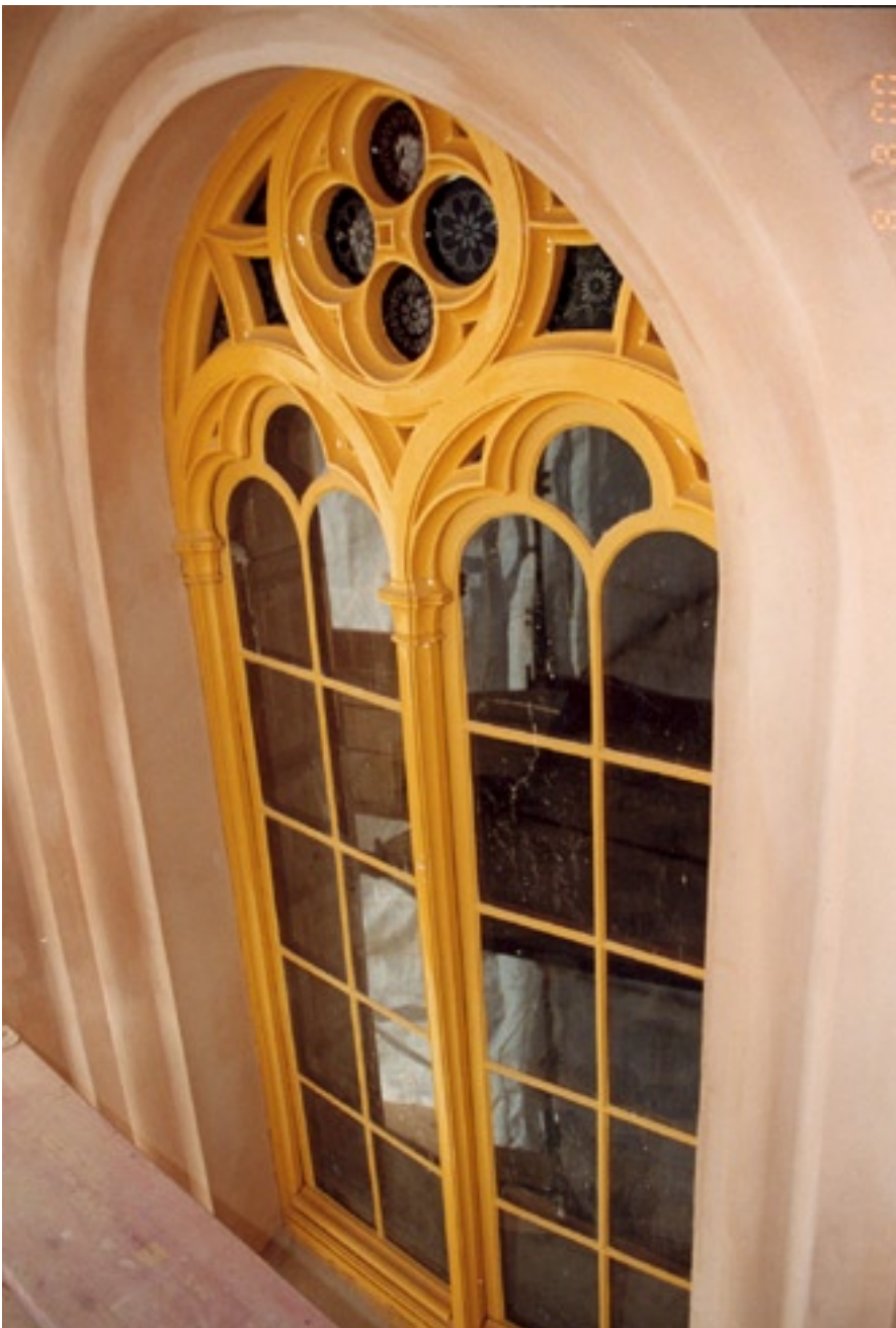
Zustand nach der Restaurierung
