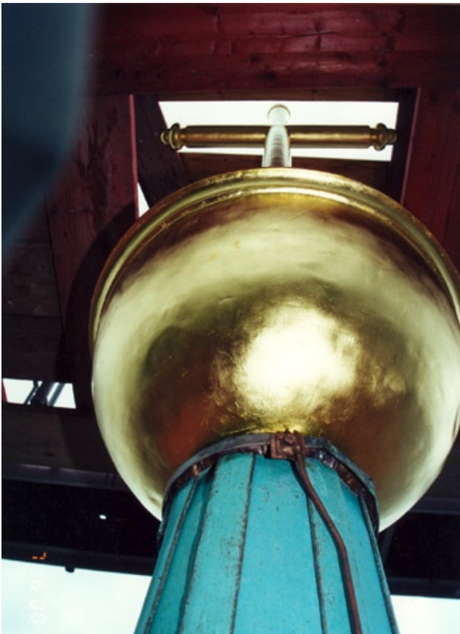
Zustand nach Fertigstellung.
