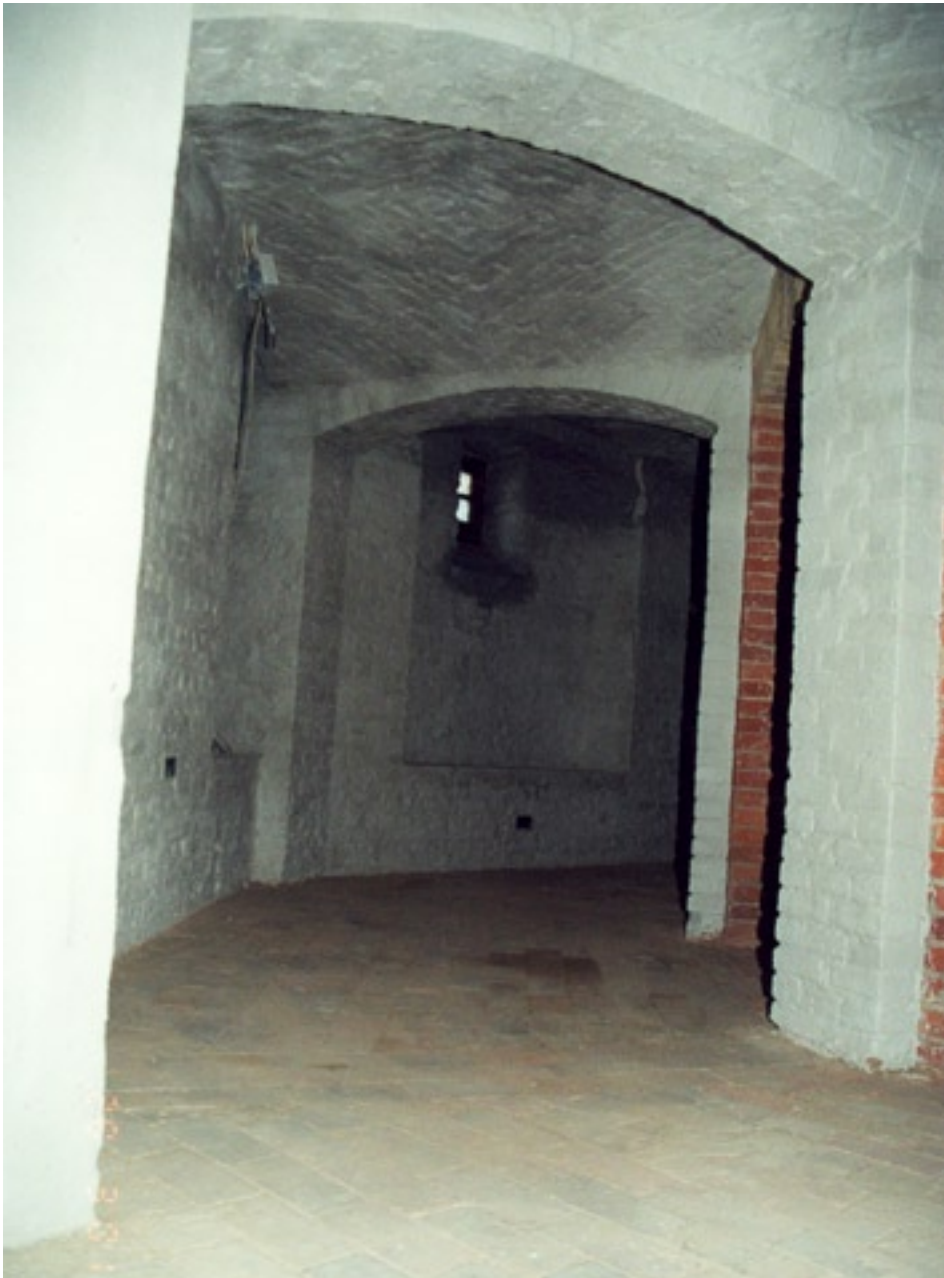
Kellerhalle nach Farbfassung in Kalkschlämme.
