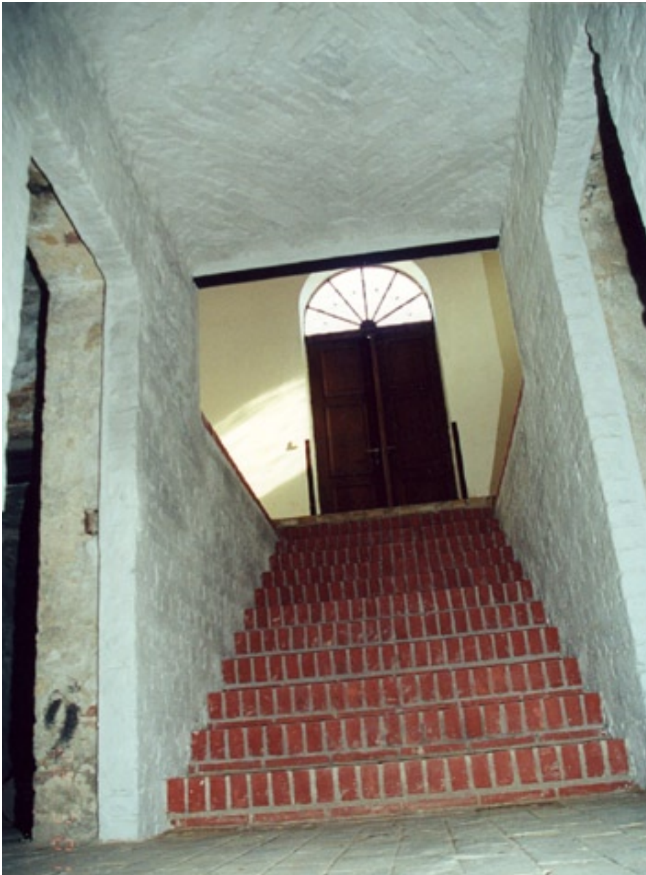
Zustand der Treppe nach der Fertigstellung.
