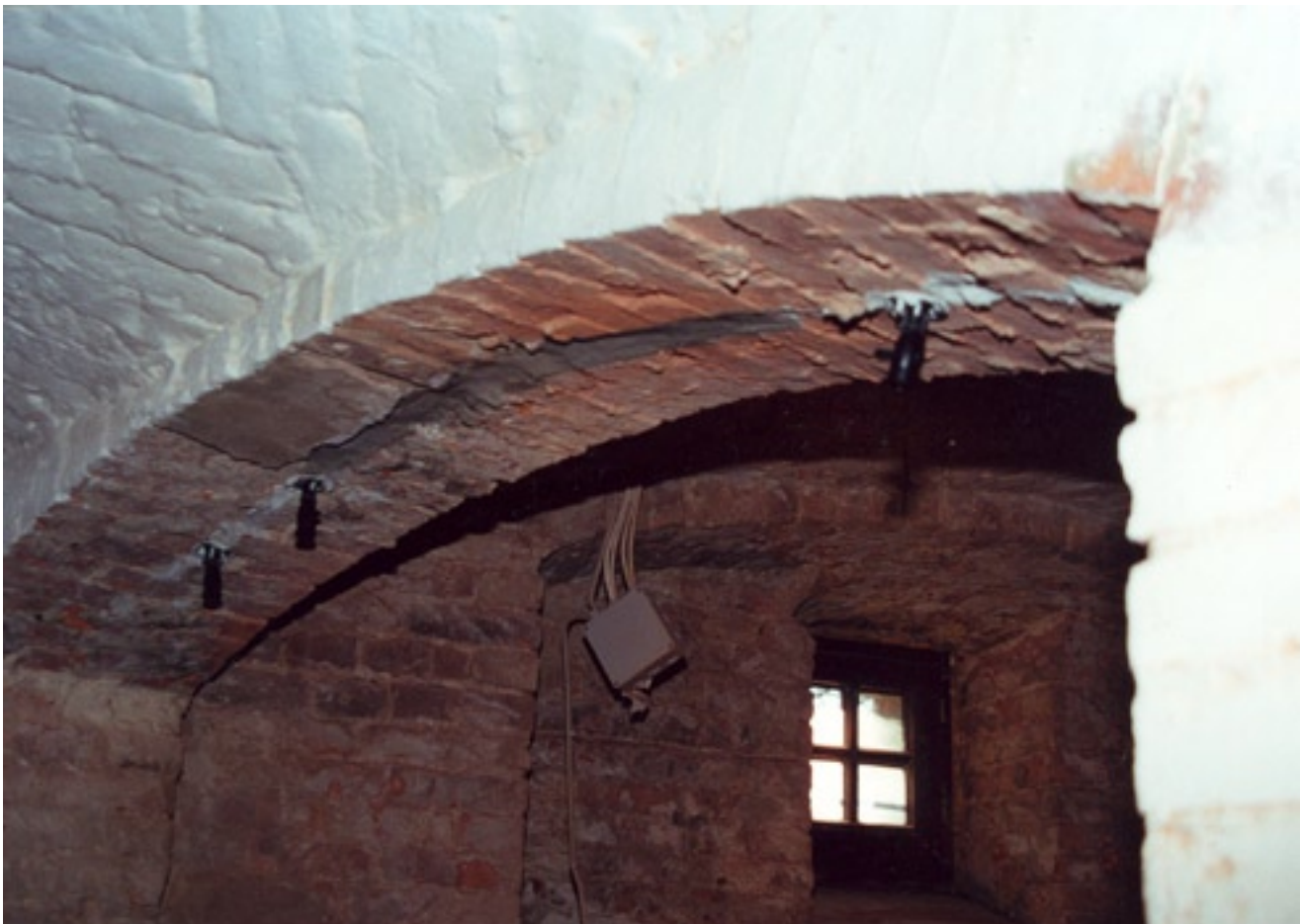
Risssanierung im Gewölbe.
