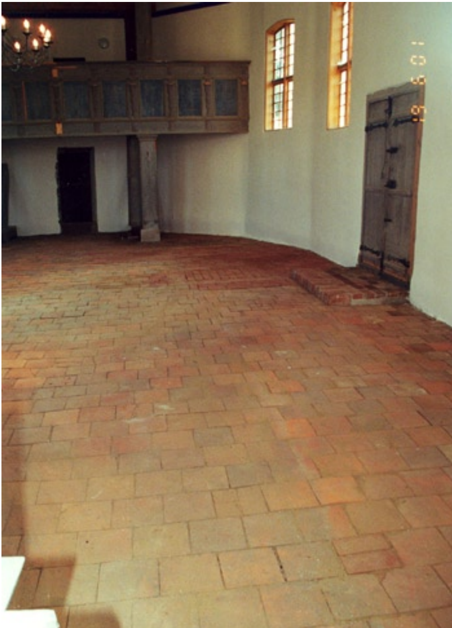
Innenraum nach Fertigstellung der Arbeiten.
