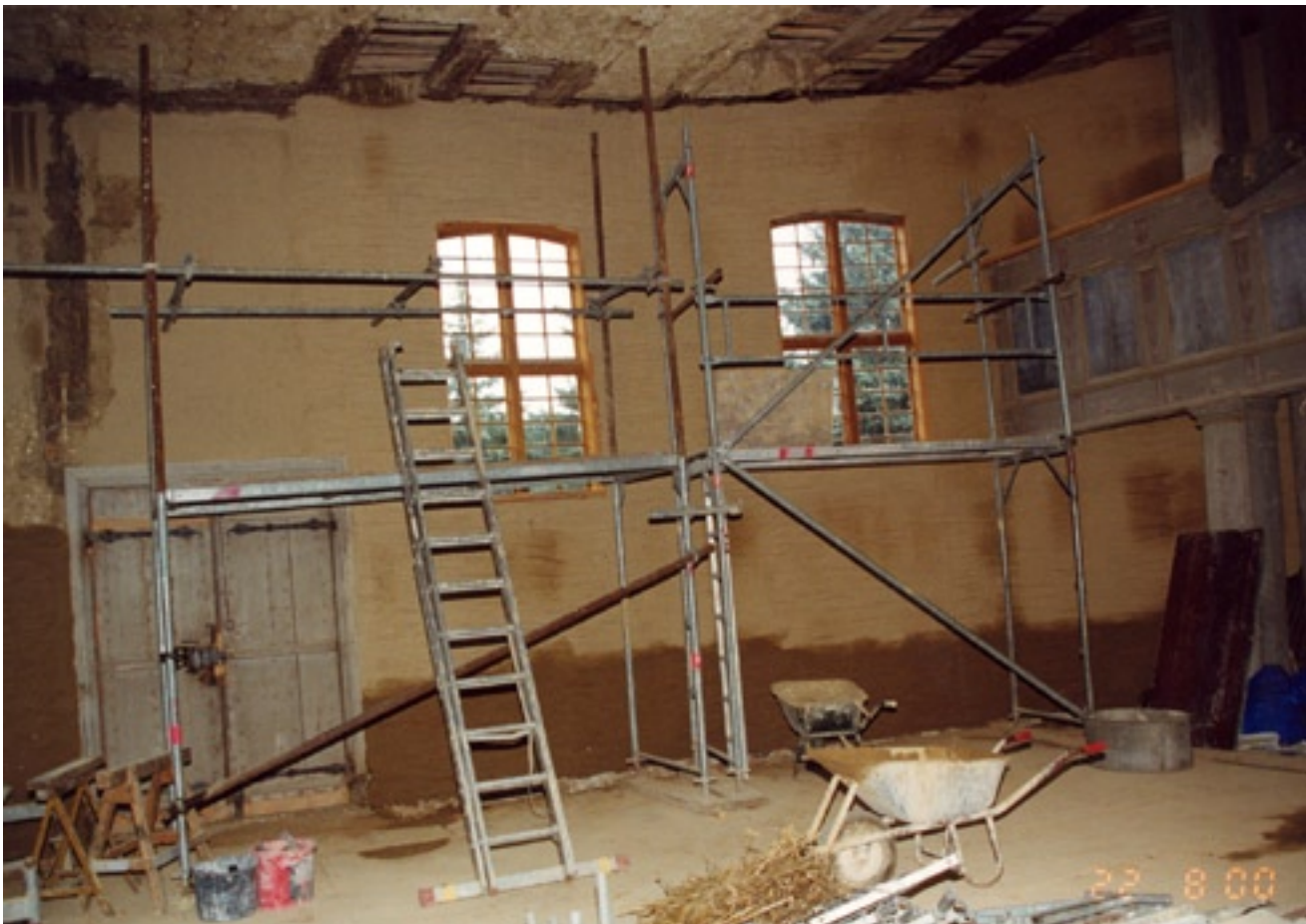
Zwischenzustand bei Lehmputzarbeiten.
