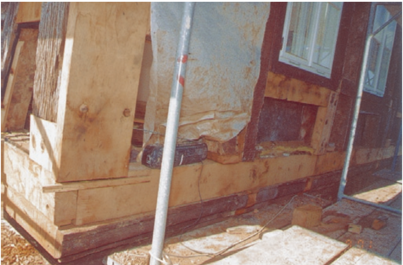
Detailansicht des teilweise ersetzten Fachwerks.
