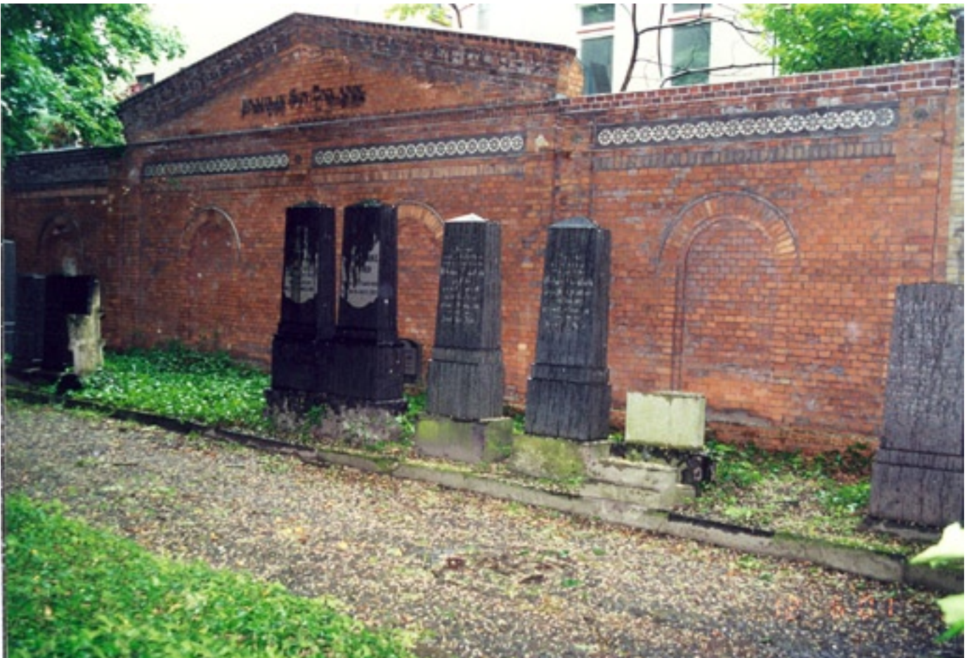
Zustand nach der Sicherung der Grabanlage Familie Schönlack.
