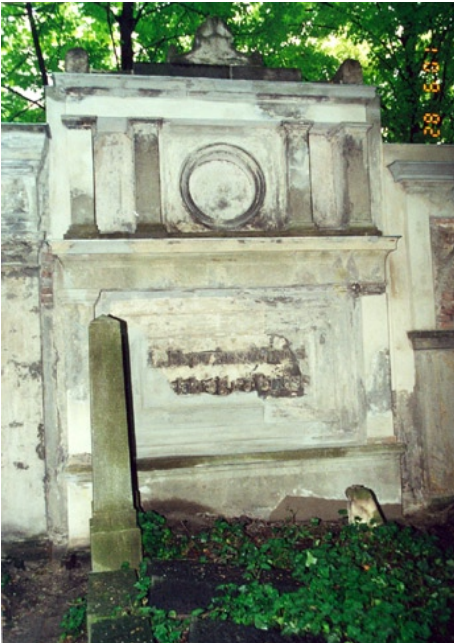
Zustand nach Fertigstellung.
