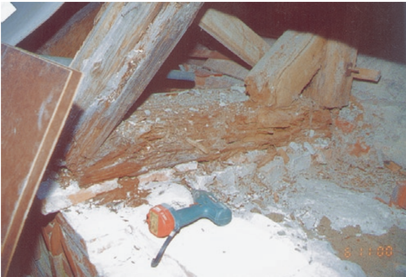
Zwischenzustand nach dem Freilegen
