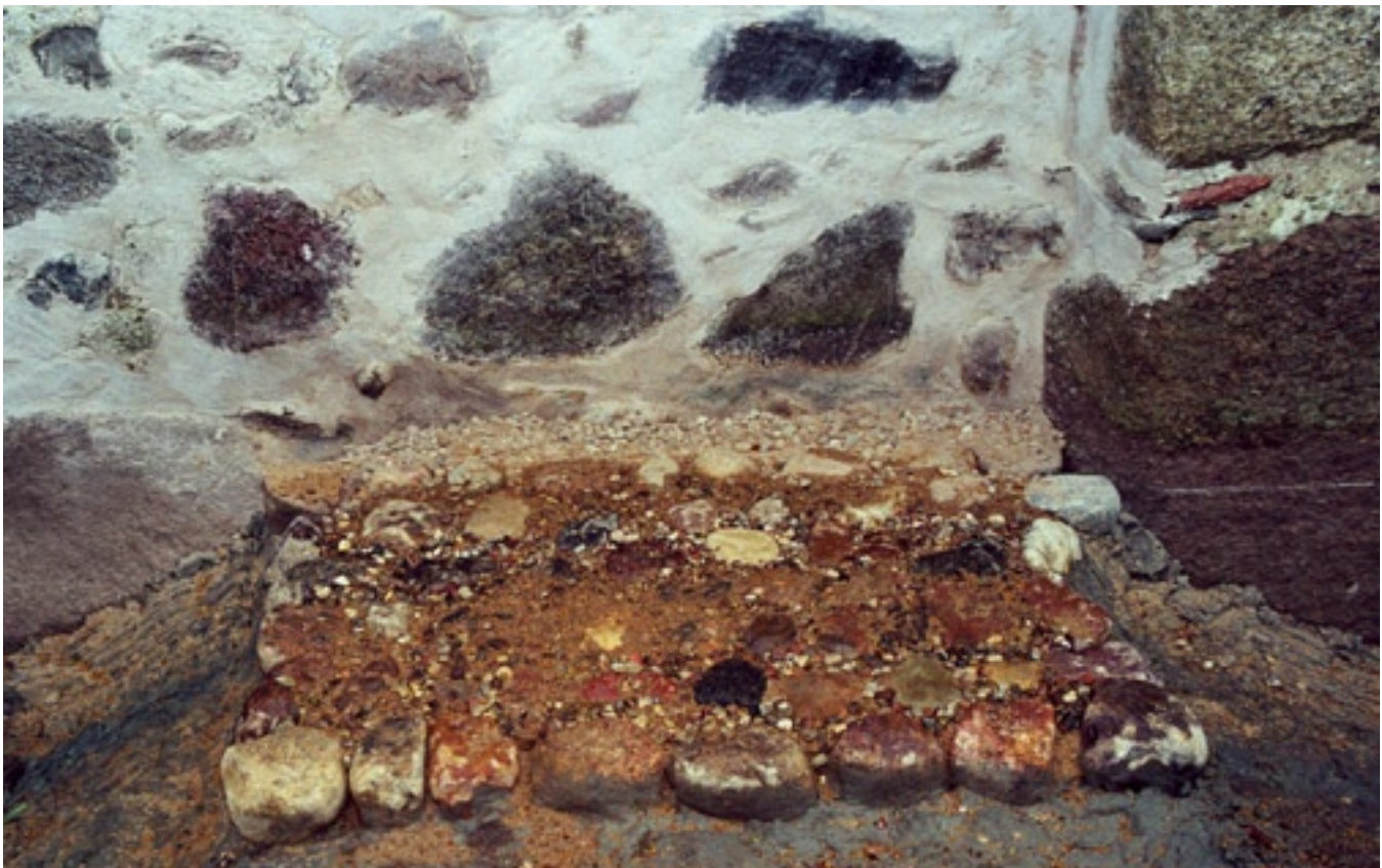
Kirche Laase, nach Mauerwerksrestaurierung. Anlegen des Traufpflasters.
