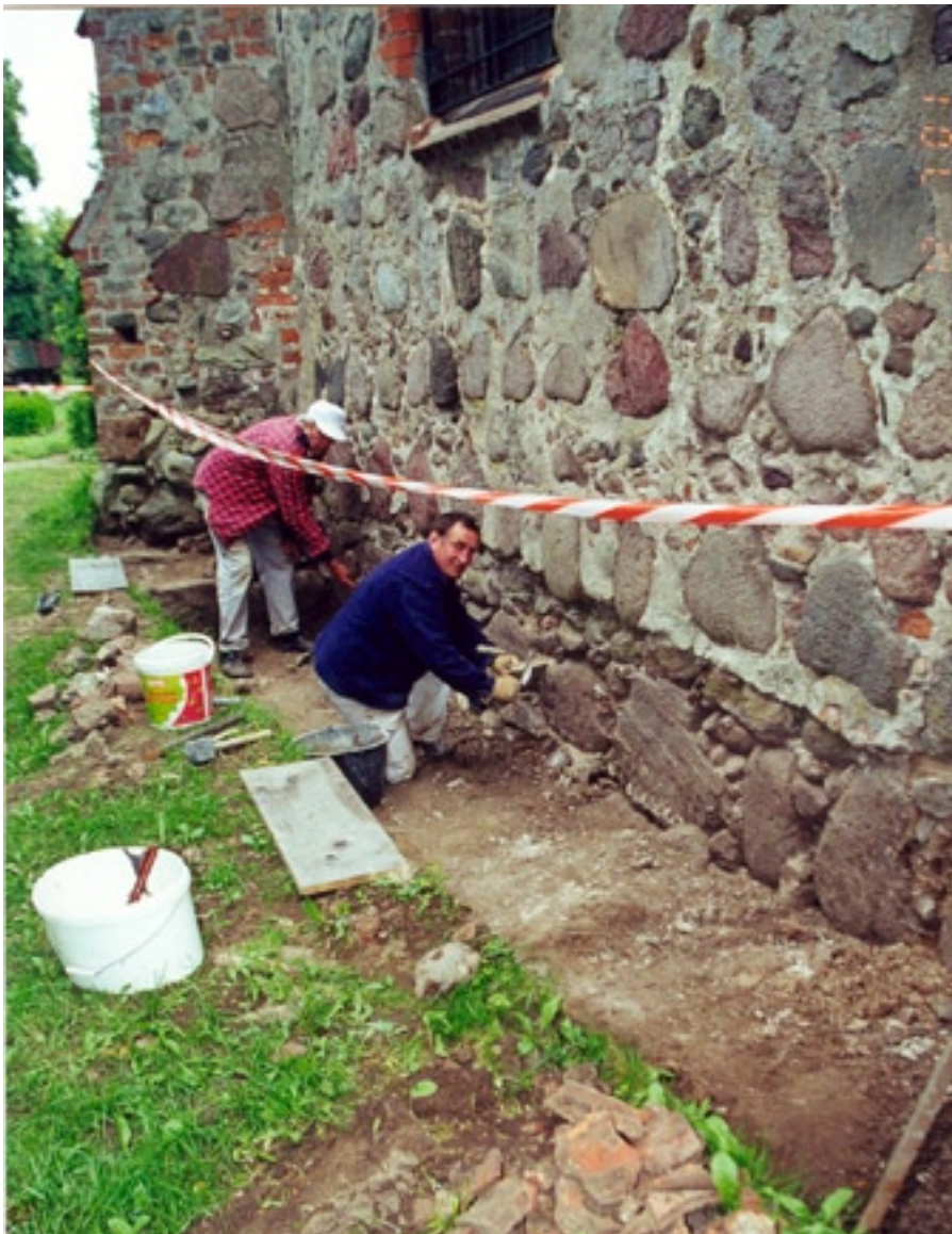
Kirche Laase nach der Freilegung während der Mauerrestaurierung.
