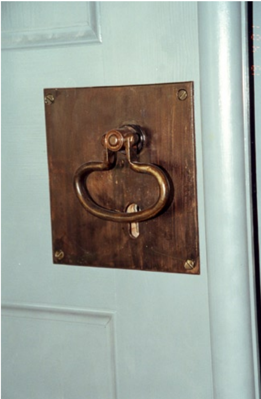
Zustand der Beschläge nach der Fertigstellung
