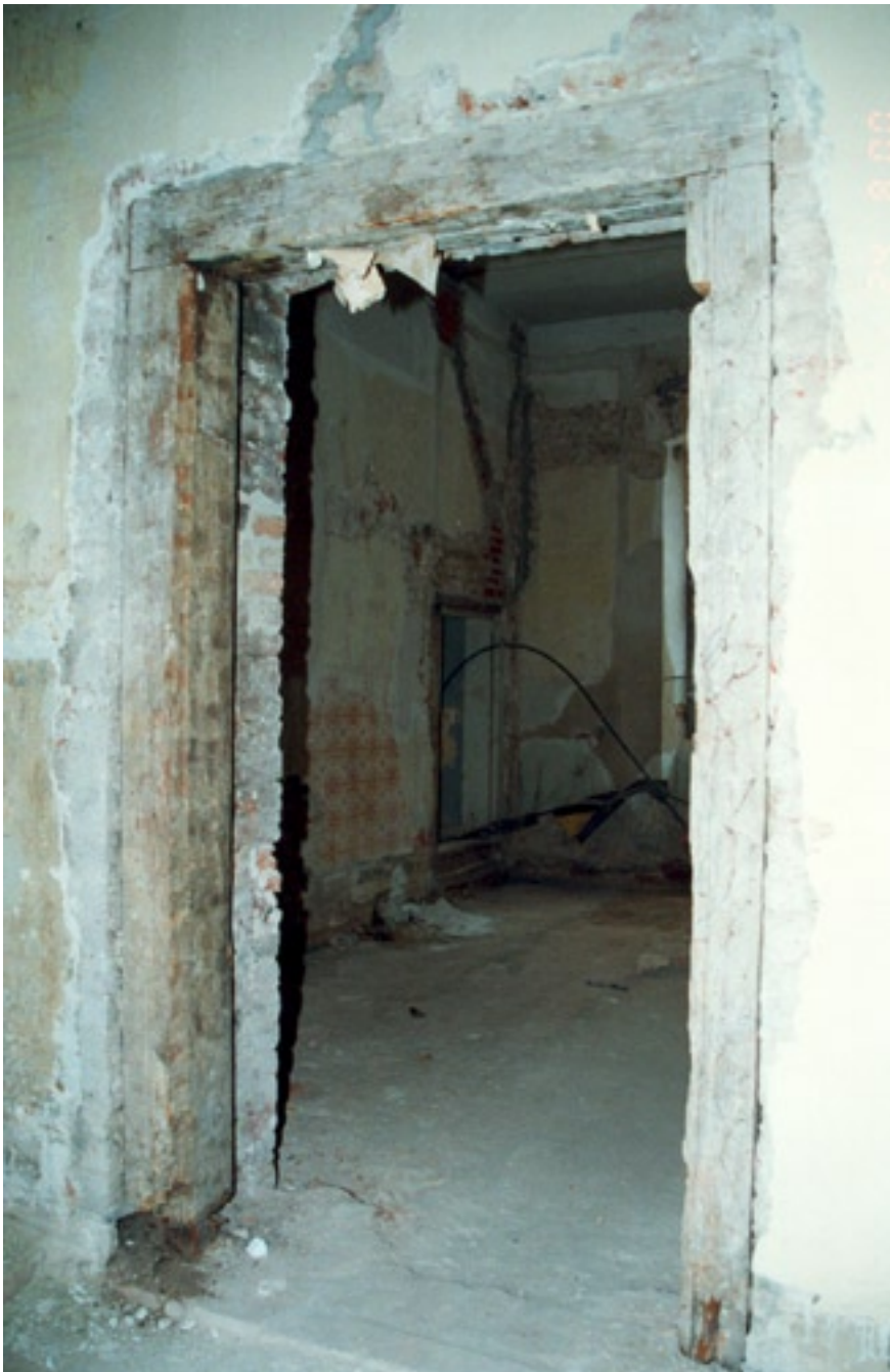
Vorzustand der Zargen
