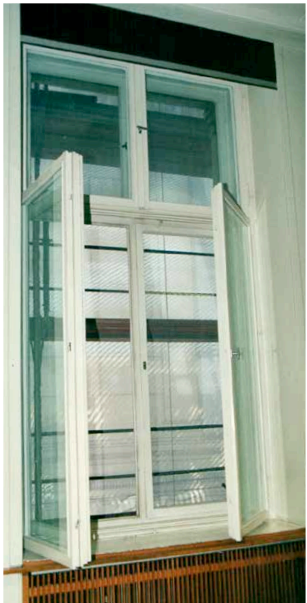
Detailaufnahme Endzustand eines Außenfensters und Innenfenster nach Fertigstellung der Arbeiten
