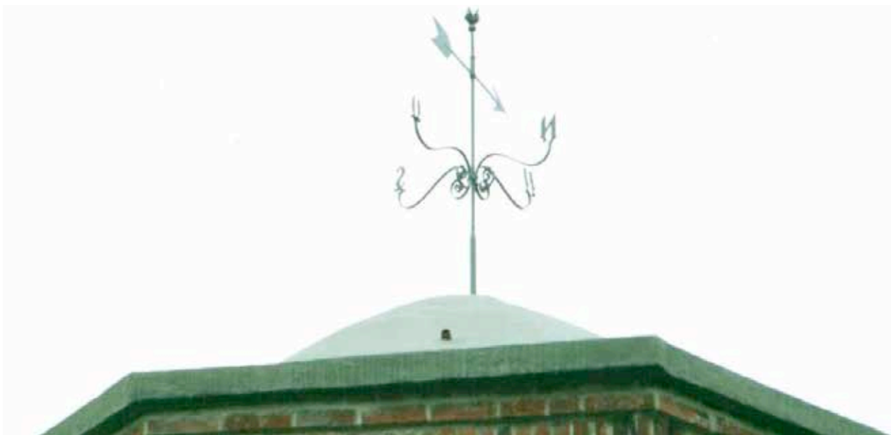
Dach nach Sicherungs- und Restaurierungsarbeiten 2006
