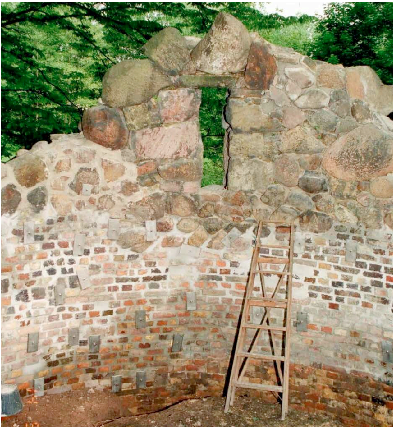
Innenansicht nach Abschluß der Arbeiten
