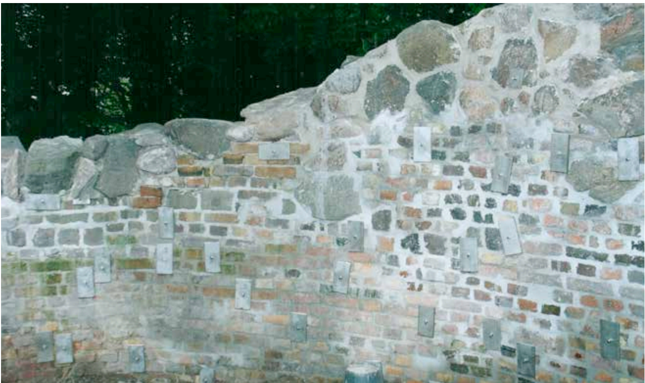
Denkmal Zyklopenmauer Braunsberg vor und nach Fertigstellung der Arbeiten
