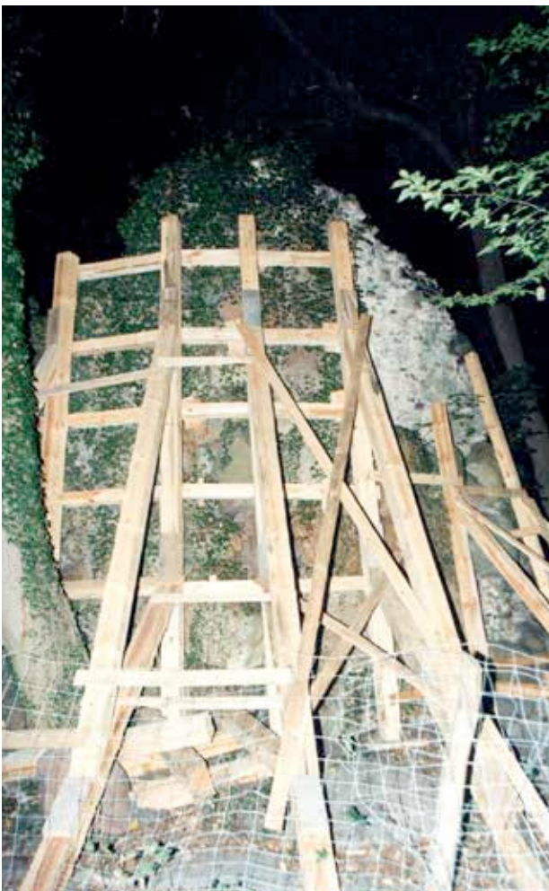
Außensicherung und Verfugung, Zustand während der Sanierung
