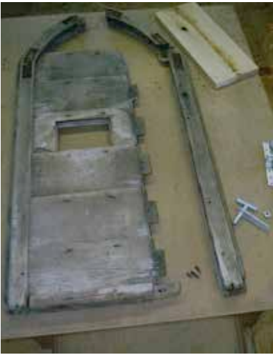
Zwischenzustand kleine Schallluke während der Restaurierung und Treppenneubau
