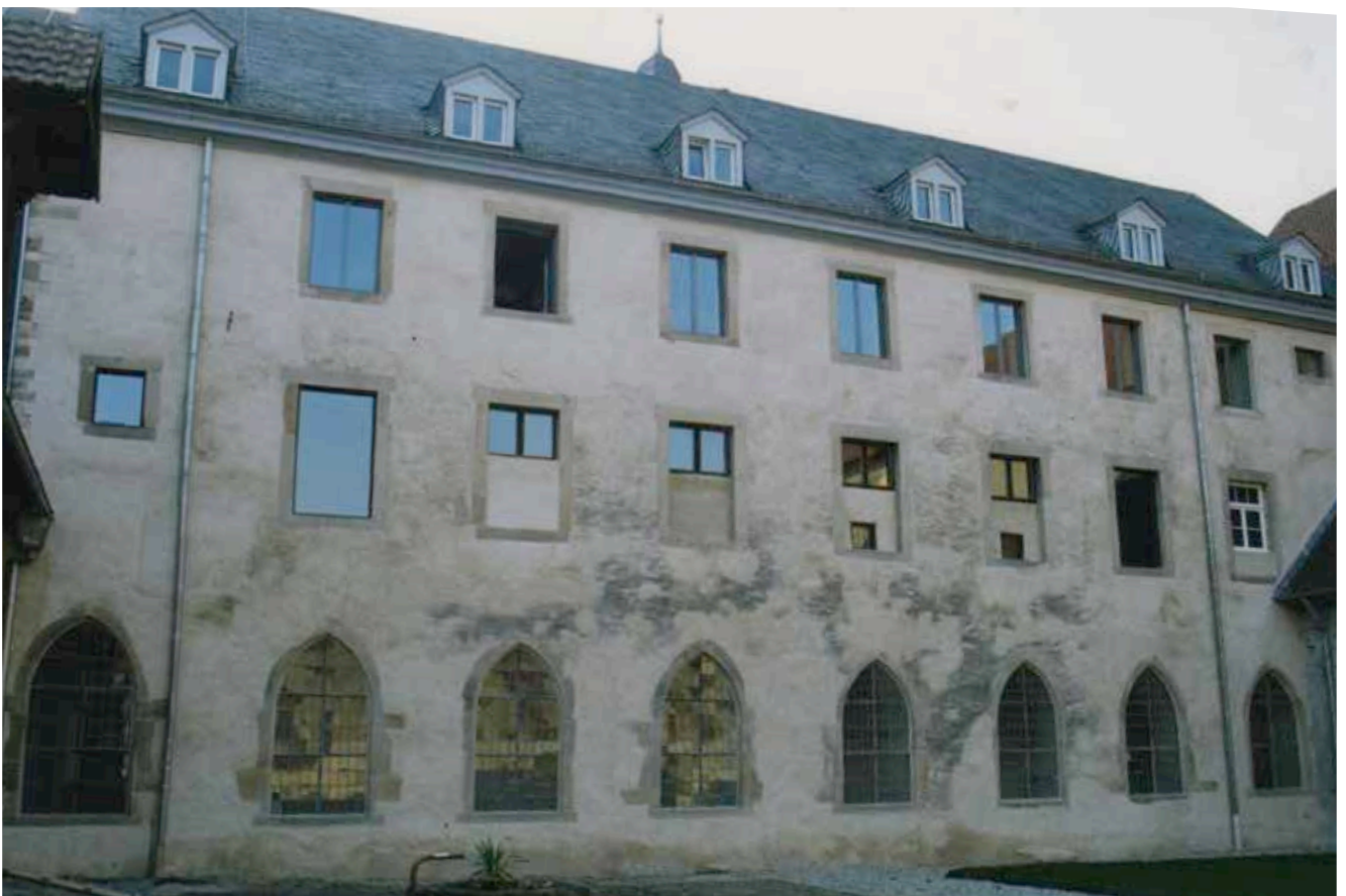
Zustand nach Fertigstellung
