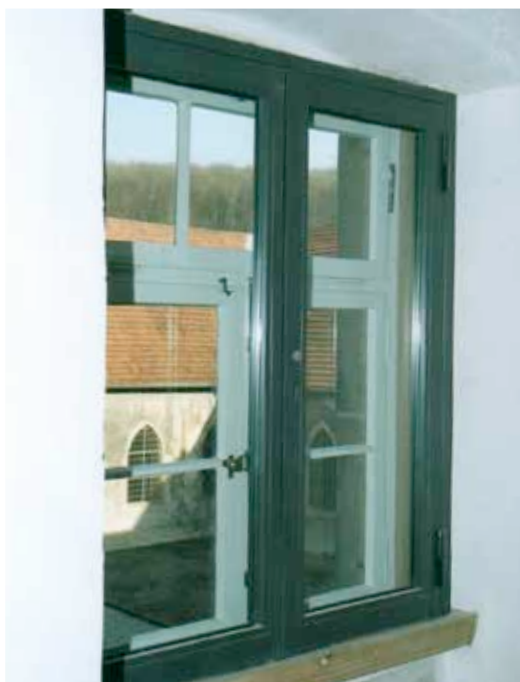
Zustand inneres Vorsatzfenster nach Einbau
