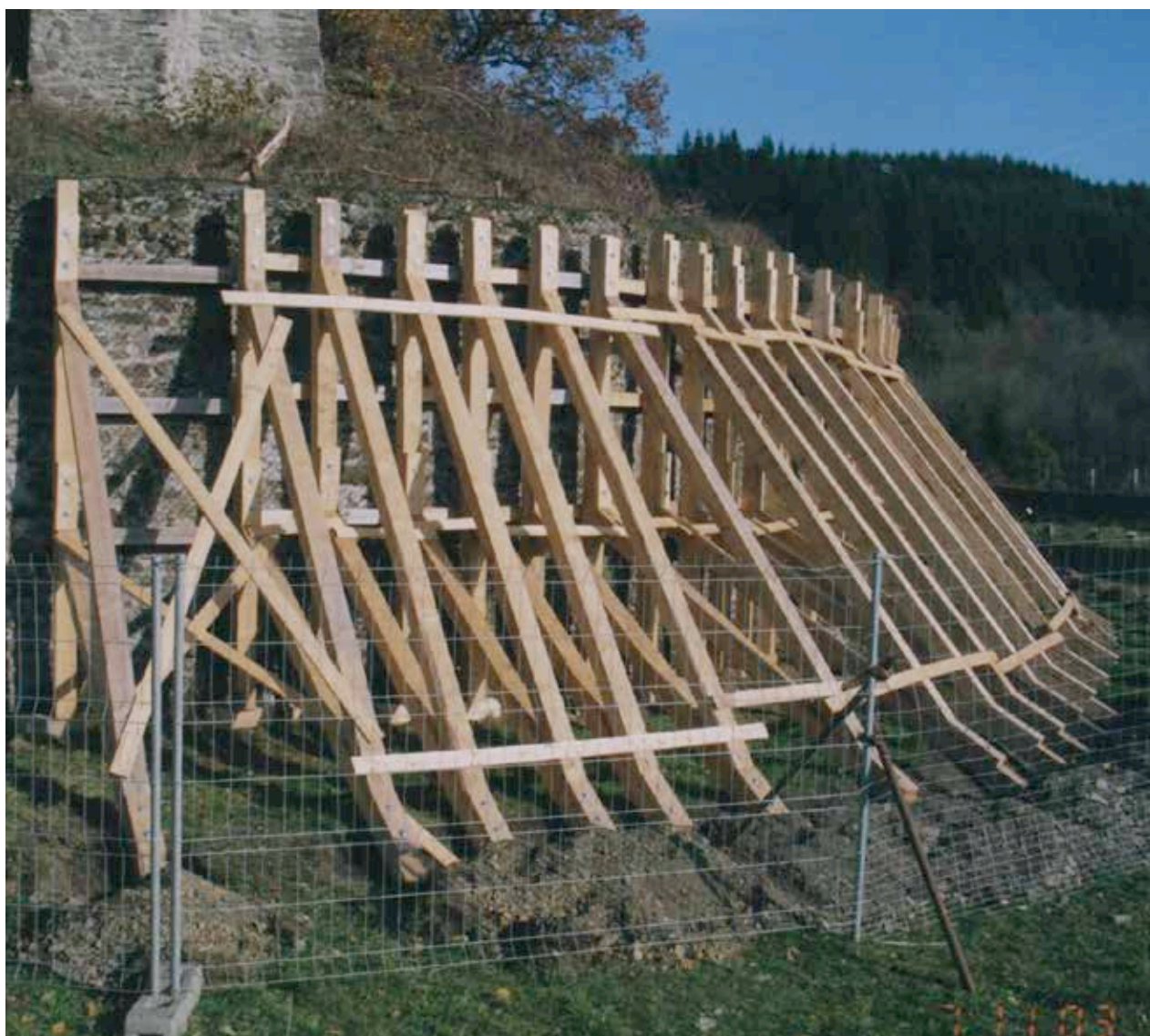
Innerer Stützmauerring der Burgruine Dasburg nach Fertigstellung
