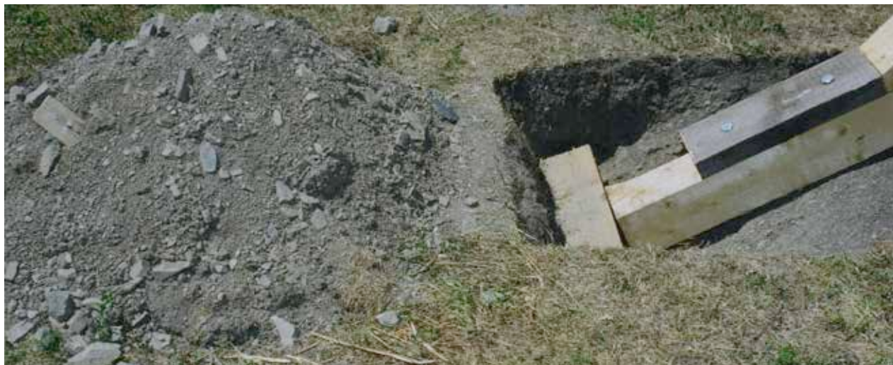
Detail Zwischenzustand Notsicherungsmaßnahme am inneren Stützmauerring
