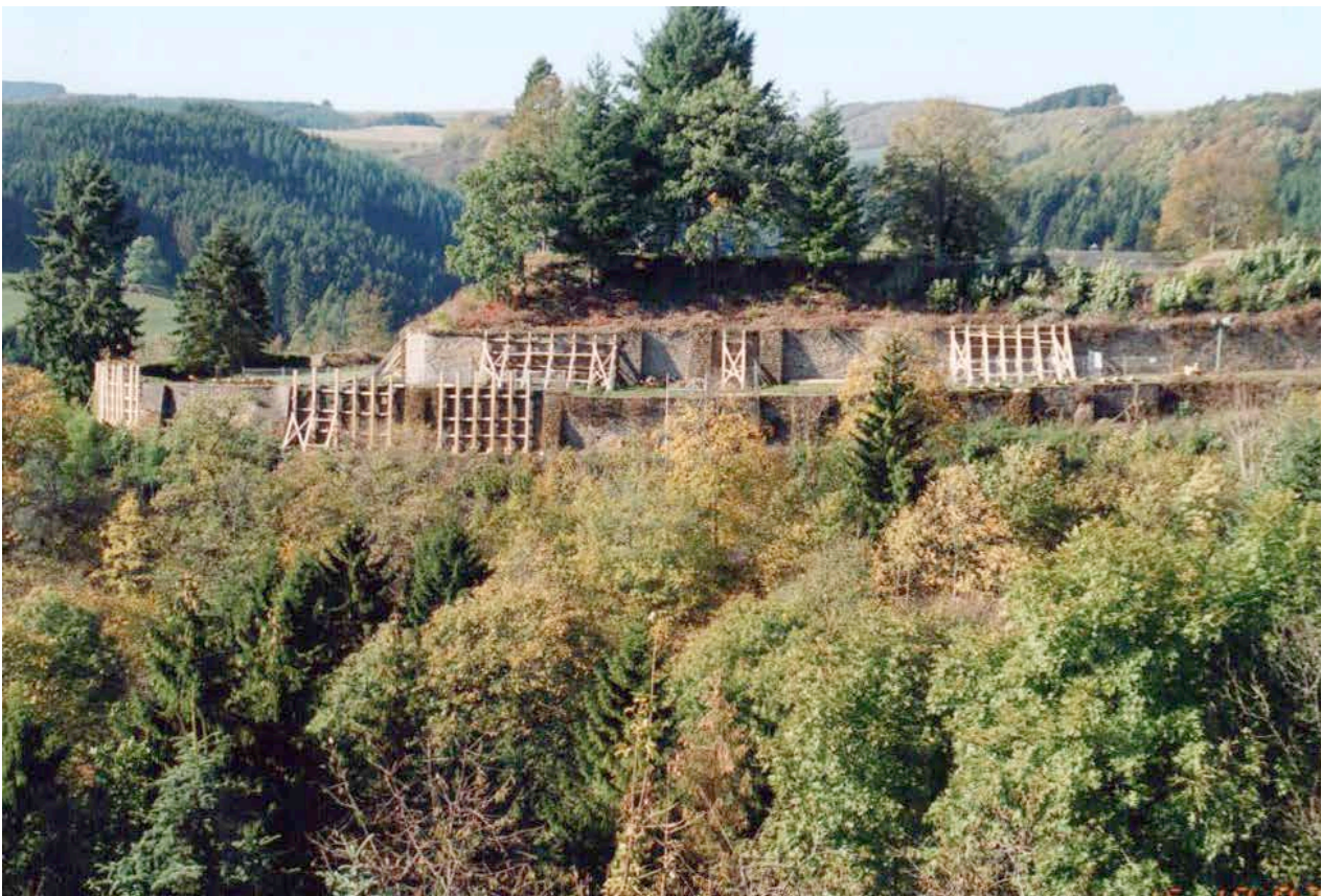
Stützmauerring nach Fertigstellung
