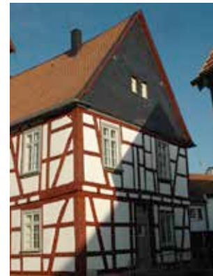
Ansicht des alten Rathauses von der Strasse aus
