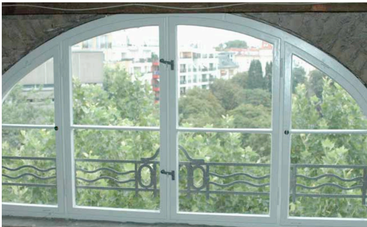
Ansicht Fenster Dachgeschoß zur Fertigstellung
