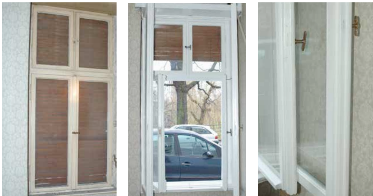
Restaurierung Fenster im Erdgeschoss vor und nach Abschluß der Arbeiten
