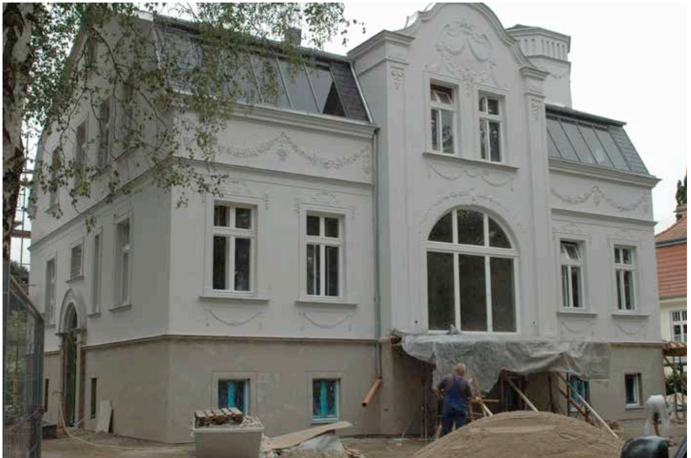
Wohnhaus vor, während und nach nach denkmalpflegerischer Instandsetzung
