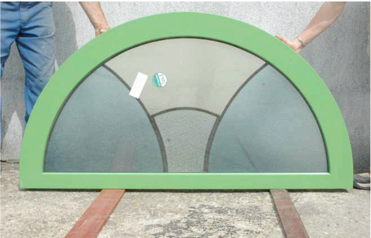
Details Bleiverglasungsarbeiten an der Haupttür, Zwischenzustand
