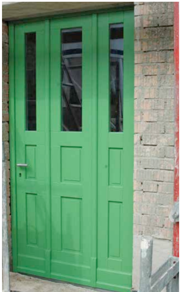
Beispiel Innentür und Nebentür nach denkmalpflegerischer Instandsetzung
