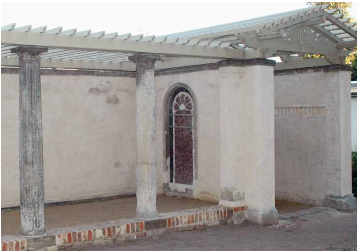
Die Pergola vor und nach Fertigstellung der Arbeiten
