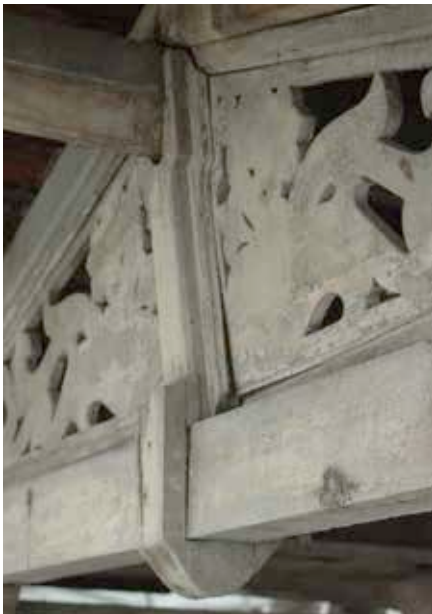
Sicherung / Freilegen des Bestandes und anschließende Restaurierung der Schnitzelemente
