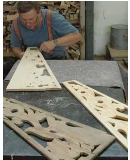
Sicherung / Freilegen des Bestandes und anschließende Restaurierung der Schnitzelemente
