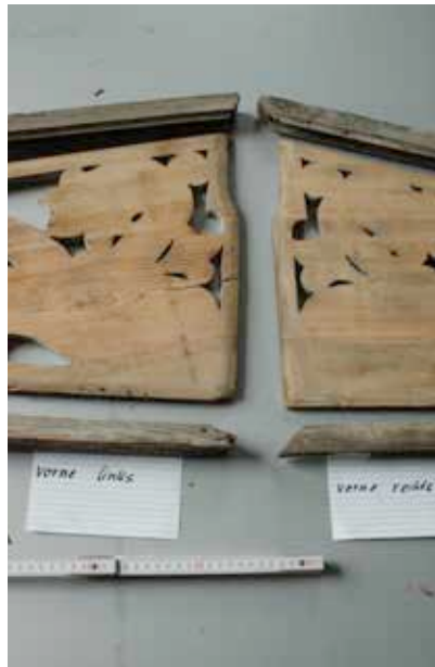
Sicherung / Freilegen des Bestandes und anschließende Restaurierung der Schnitzelemente
