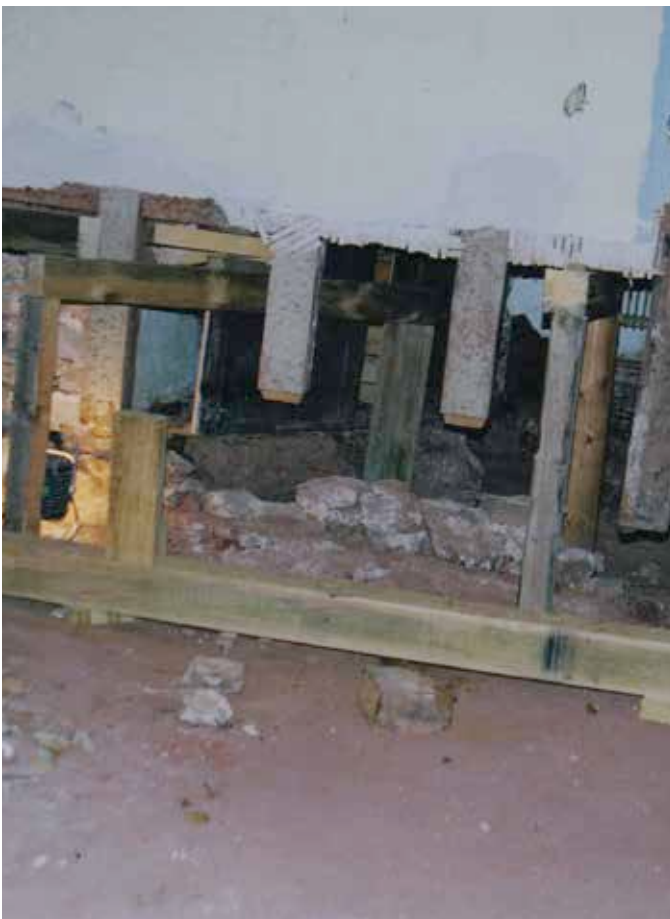
Vorzustand Fachwerkwand und Fachwerkwand mit Passstücken
