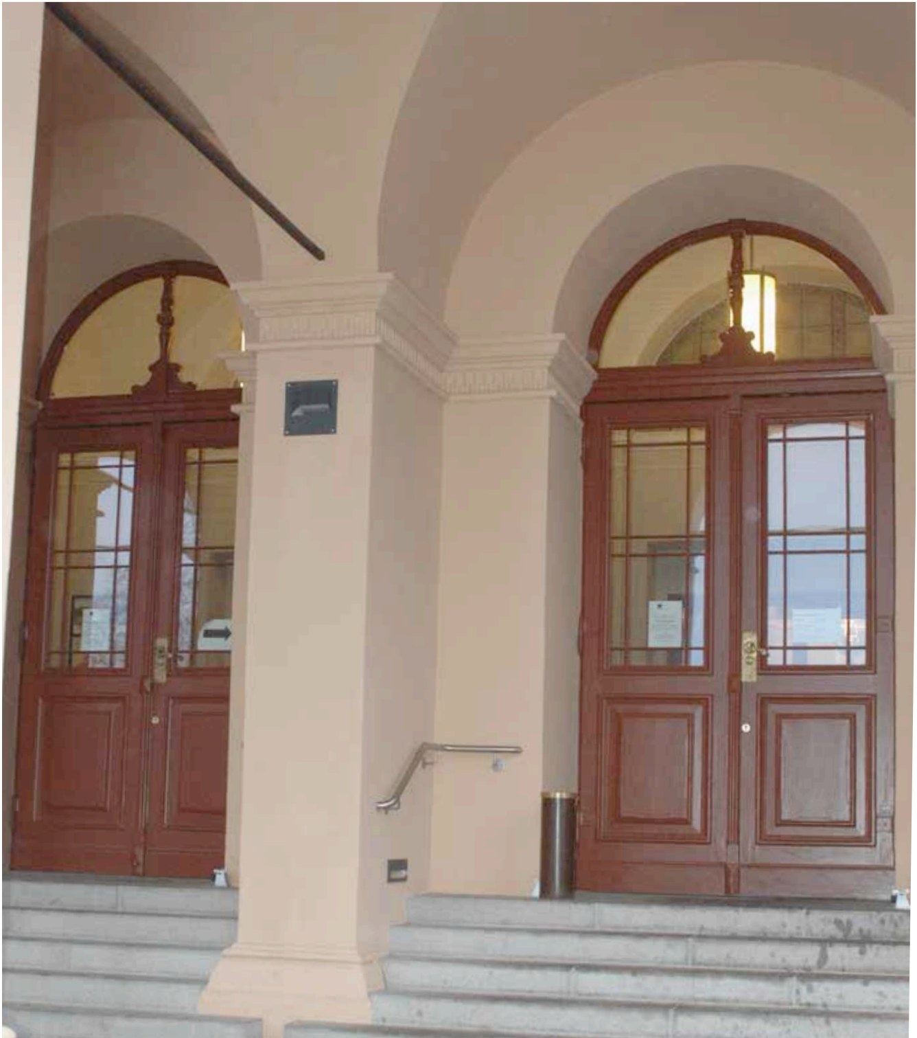
Portaltüren nach Fertigstellung der Arbeiten
