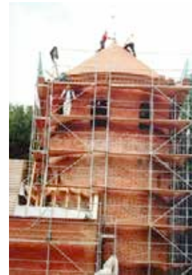
Montage der restaurierten Burgspitze
