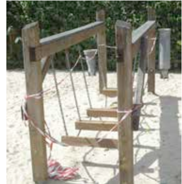
Klettergerüst vor der Rekonstruktion
