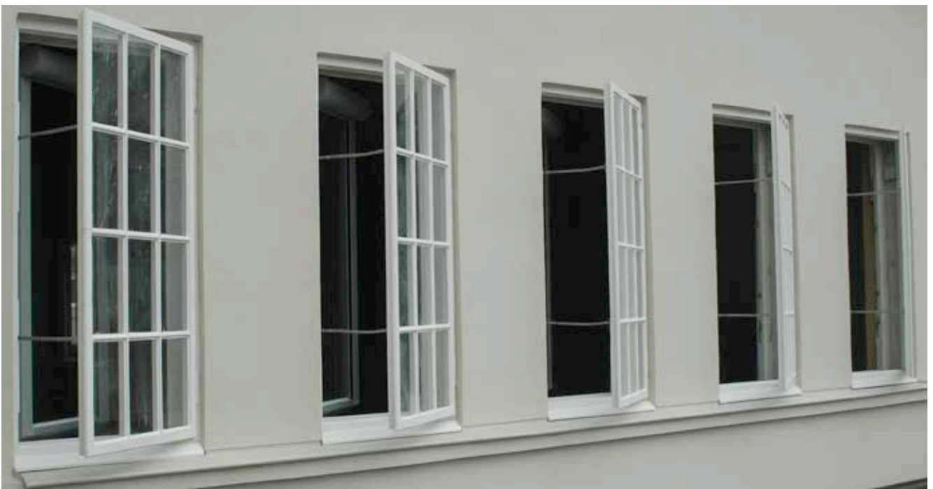
Ansicht restaurierte Galerie im Obergeschoß mit GEZE Öffnungsmechanismen
