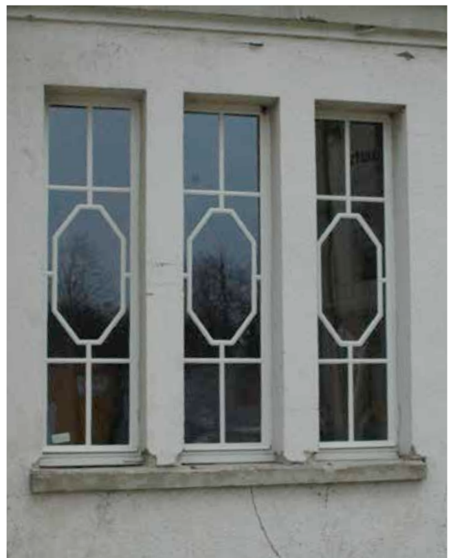
Restaurierung Kastenfenster und Einbau Isolierverglasung mit Wienersprosse
