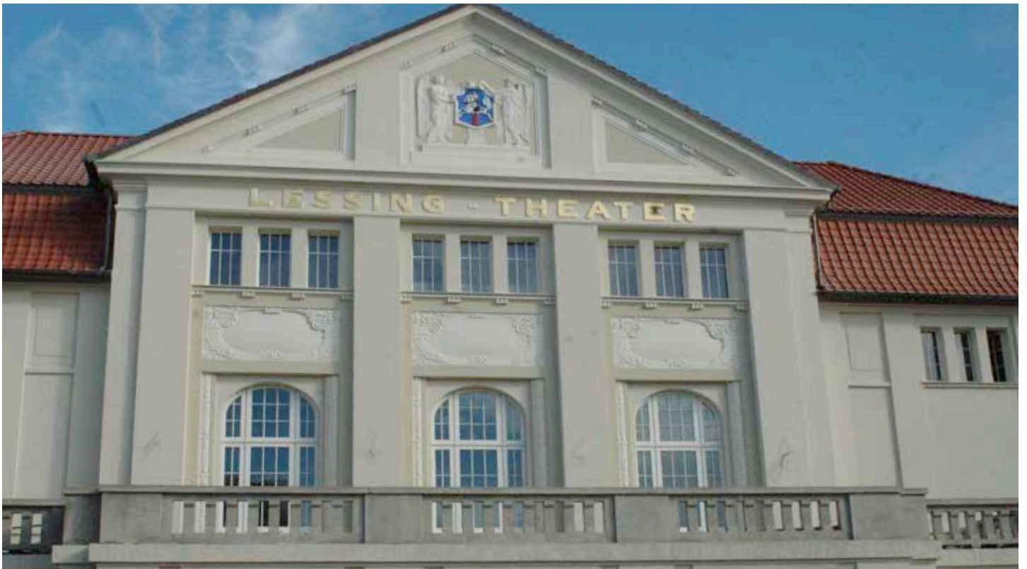
Einbau Eingangstüren und Fassadenansicht nach Fertigstellung der Arbeiten
