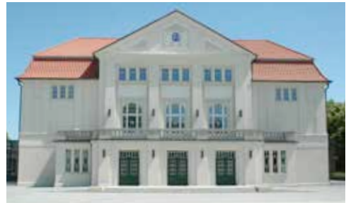
Fertig restaurierter Haupteingang zum Theater
