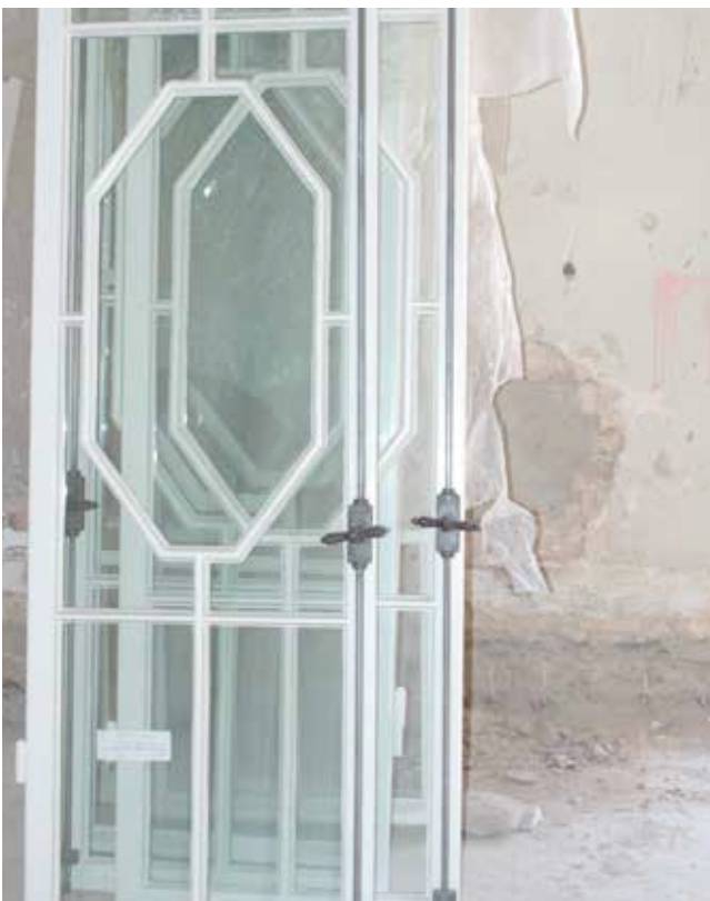
Restaurierung Kastenfenster und Einbau Isolierverglasung mit Wienersprosse
