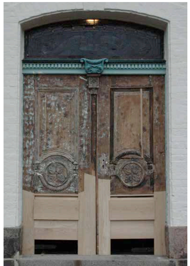
Zustand einer der 4 historischen Aussentüranlagen vor und während der Restaurierung
