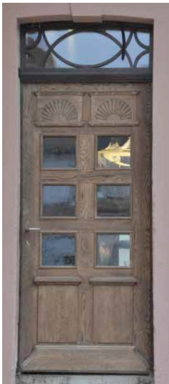
Innen- und Außenansicht wärmedämmte Außentür Neubau in Form und Gestalt nach historischem Vorbild
