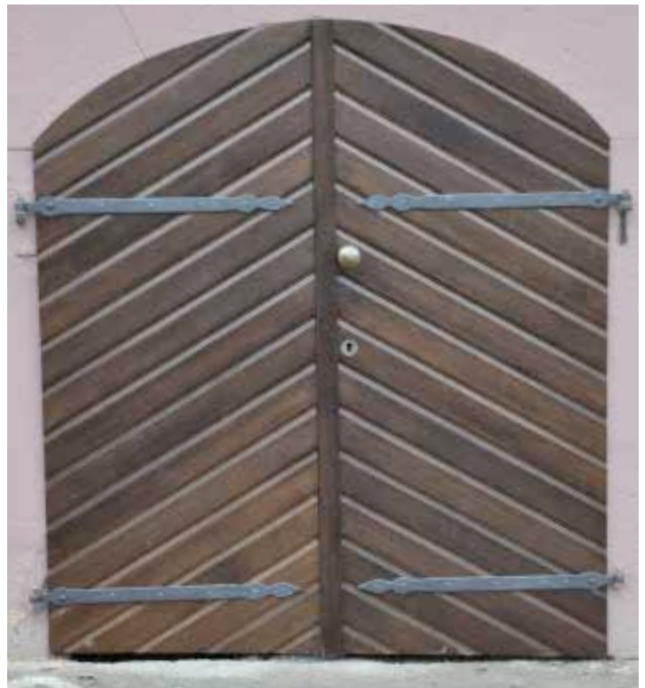
Neubau Außentür nach historischem Vorbild
