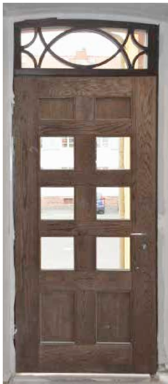
Innen- und Außenansicht wärmedämmte Außentür Neubau in Form und Gestalt nach historischem Vorbild
