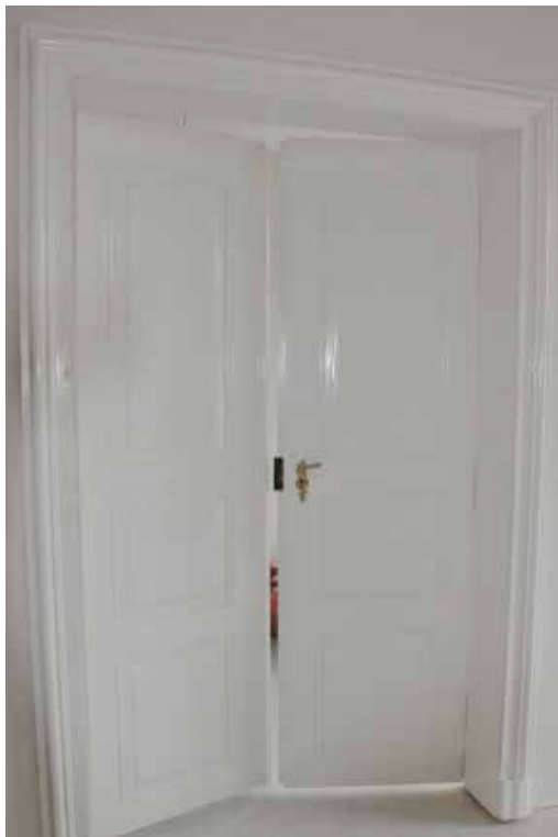
restaurierte Innentür nach Abschluss der Arbeiten
