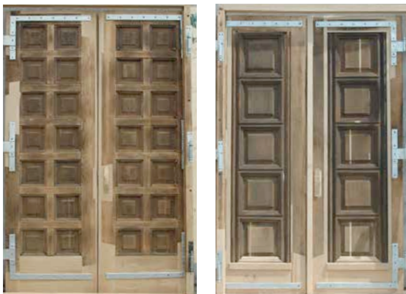
Außentüren während der Freilege- und Ergänzungsarbeiten
