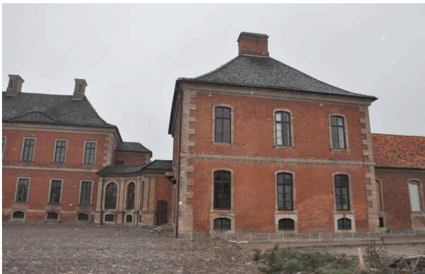
Schlossanlage Bothmer zu Beginn der Arbeiten
