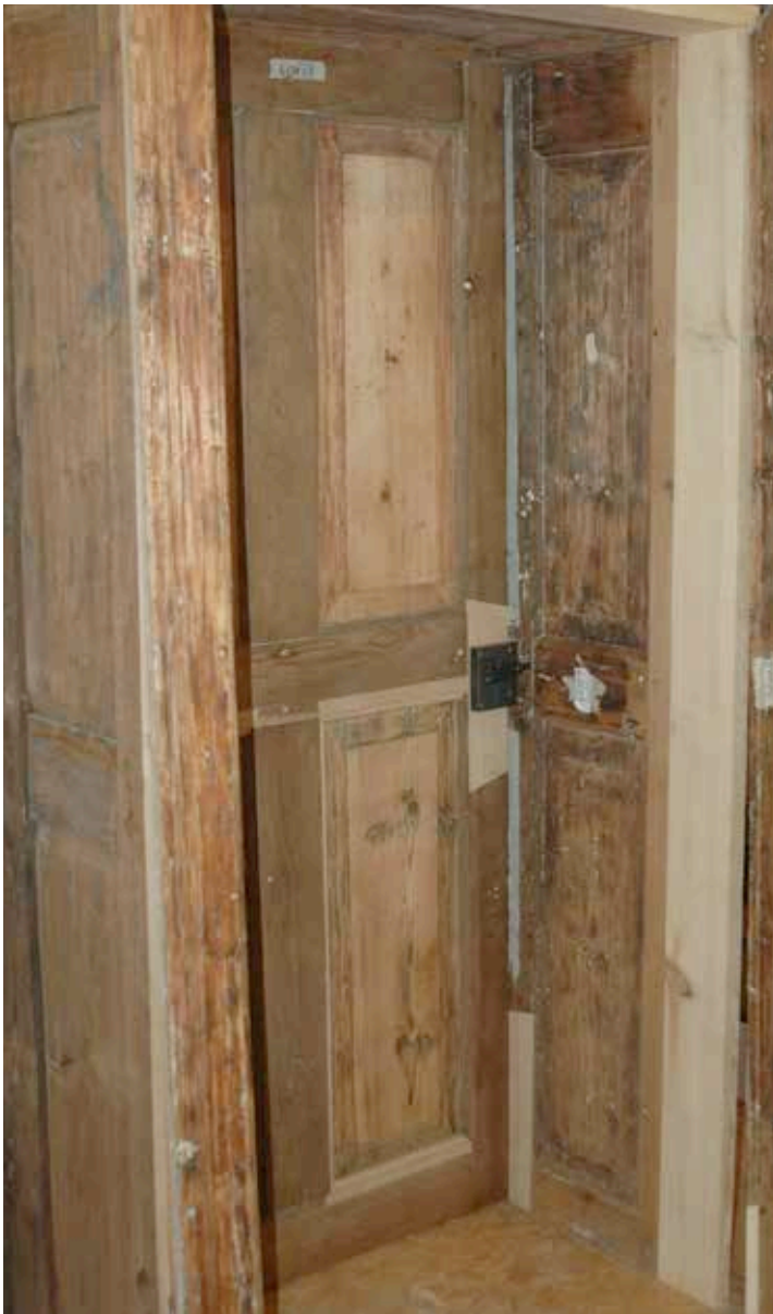
Freigelegte Innentür während Instandsetzung / Ergänzung und nach den Restaurierungsarbeiten
