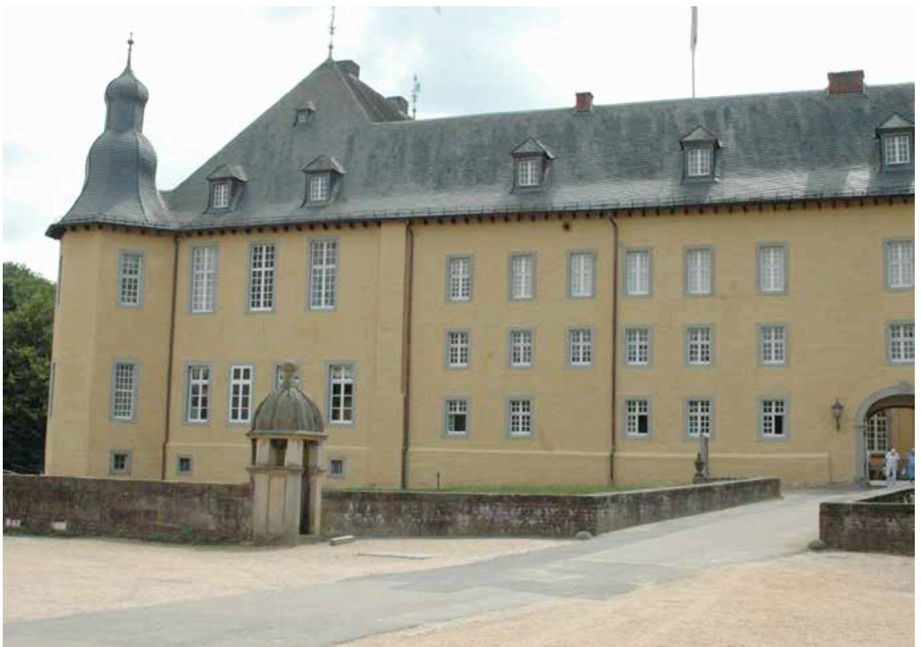
Schloss Dyk nach Fertigstellung der Arbeiten
