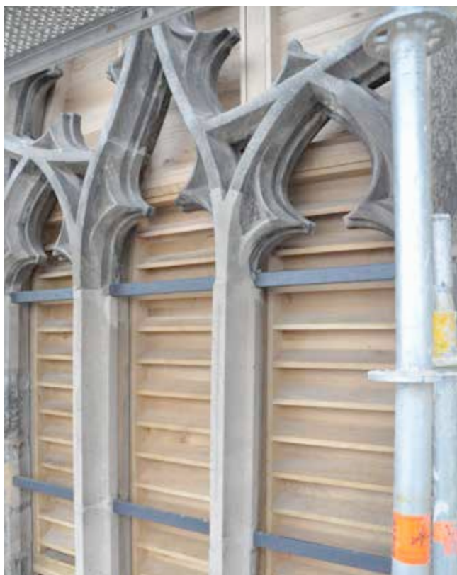
Schallluken Vorzustand und Zustand nach Fertigstellung der Arbeiten im Südturm
