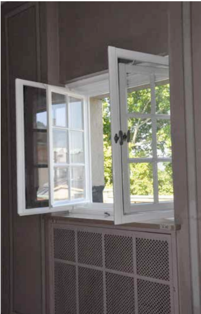
Zustand Fensteranlage nach Fertigstellung (Restaurierung Außenfenster und Vorsetzen von Innenfenstern)
