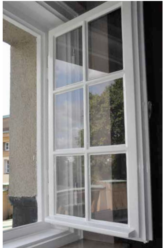
Zustand Fensteranlage nach Fertigstellung (Restaurierung Außenfenster und Vorsetzen von Innenfenstern)
