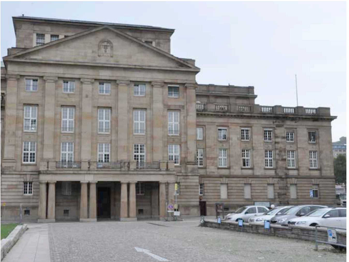
Fassadenansicht nach Fertigstellung
