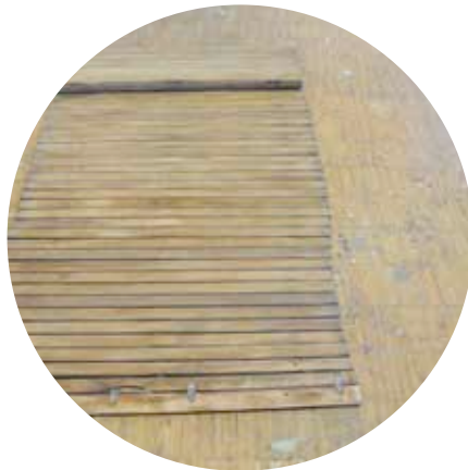
Arbeit an den Rolllädenwährend der Instandsetzung
